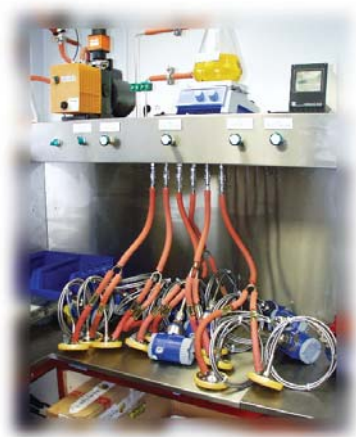
Assemblage de transmetteurs différentiels sur séparateurs.
