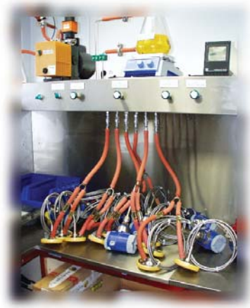
Assemblage de transmetteurs différentiels sur séparateurs.
