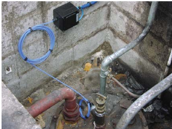
Installations et mises en service de mesures de niveau en zone ATEX.
