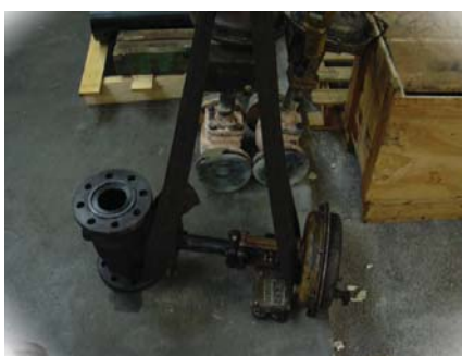
Réfection d'une vanne de régulation.
