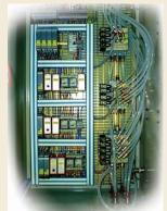
Etude, réalisation et installation d'un système de gestion de remplissage de fûts
